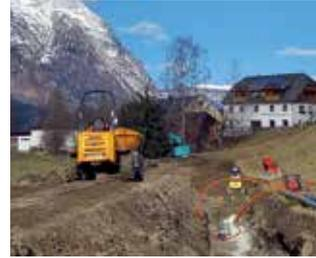
Der Glasfaserausbau ist voll angelaufen und die ersten Bauphasen konnten planmäßig abgeschlossen werden. Im ersten Schritt wurde die Verlegung der Leitungen über lange Strecken in Angriff genommen. Durch die spezielle LayJet Methode entstanden hier keine großen Verkehrsbehinderungen, da die gefräste Rille sofort wieder verschlossen wurde.
