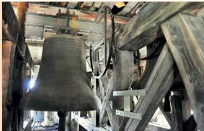
Glockenstuhl der Pfarrkirche Irdning
