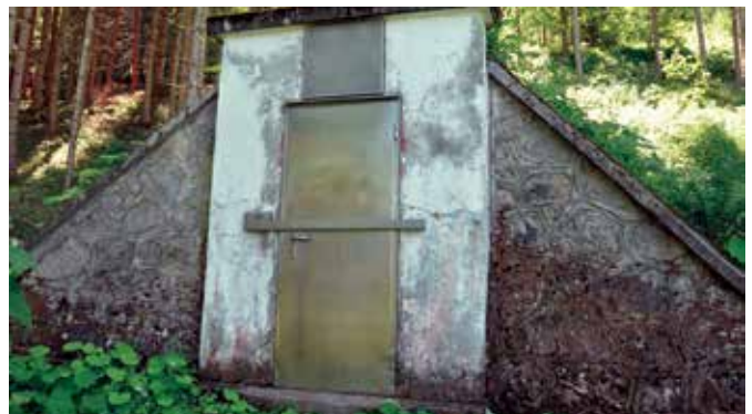
Eingang zur Irdninger Wasserversorgung
