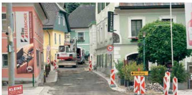
Zukunftsweisend wurden auch bereits Leerverrohrungen und Leitungen für den Breitbandausbau mitverlegt
