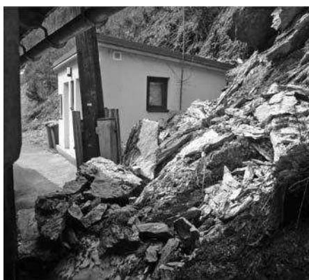
Felssturz hinterm Schützenhaus im Frühjahr 2013
