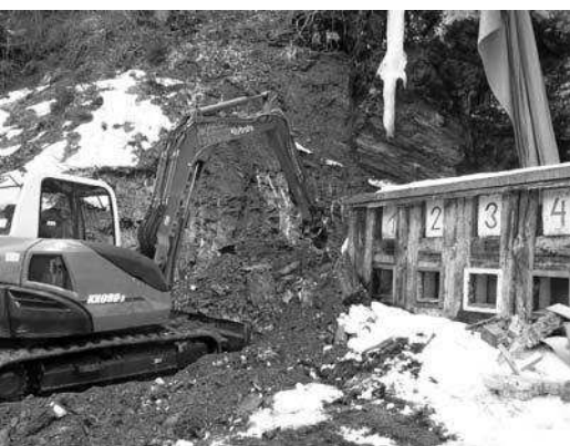
Baubeginn bei der Kugelanlage
